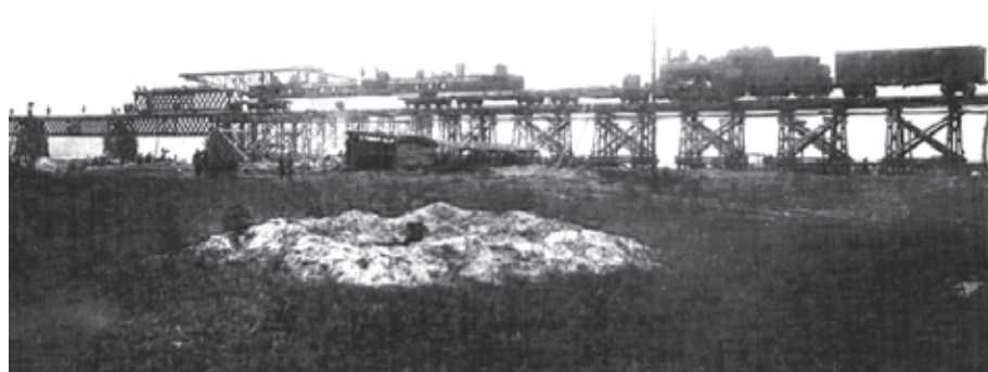
Рис. 3. Надвигка пролётного строения при помощи крана-пилон Н. А. Артеменко на сооружении моста через р. Новый Днепр
