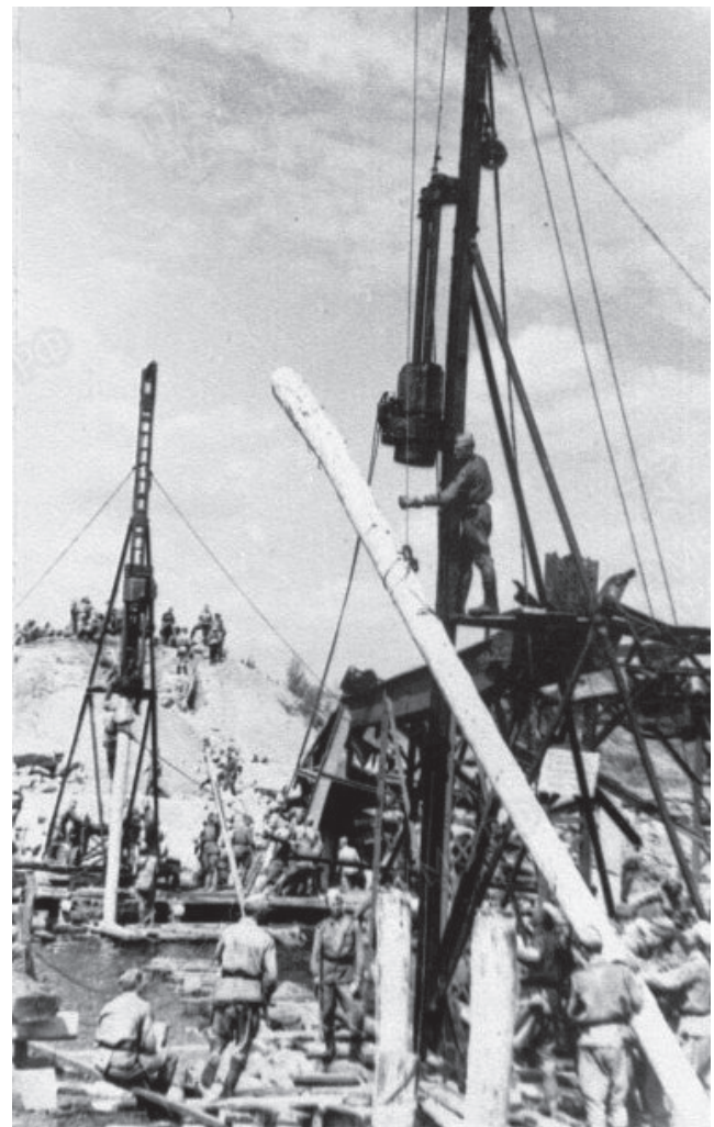
Рис. 4. Забивка свай мостовой ротой 2 омждб с применением свайного копра Н. В. Озерова в ходе строительства моста через р. Сунжа
