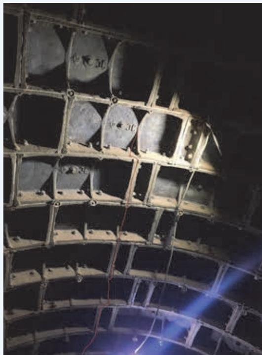
**Рис. 3. Чугунная обделка наклонного хода**
