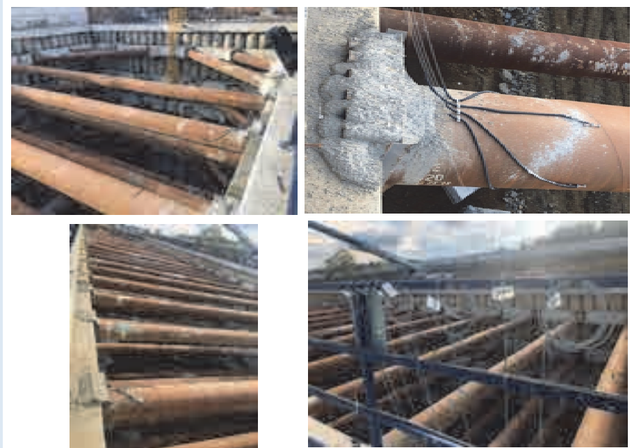
Рисунок 1. Оснащение расстрельной системы котлованов датчиками в Турции, г. Стамбул
