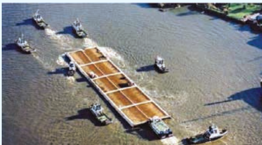
Рис. 3. Транспортировка секции тоннеля к месту установки
