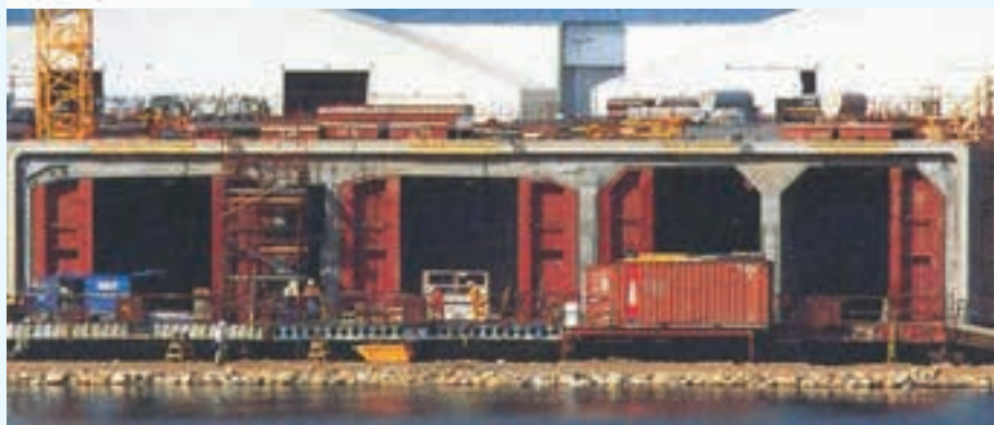
Рис. 2. Подготовка секции тоннеля к транспортировке
