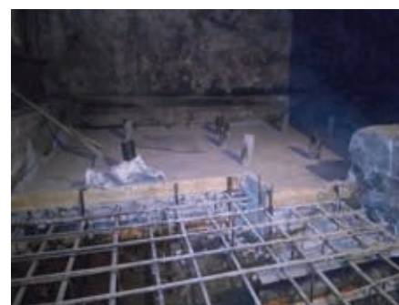
Рис. 7. Монолитная фундаментная плита с кондукторами для бурения компенсационных скважин
