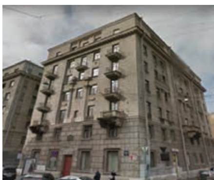
Рис. 4. Здание по ул. Декабристов, д. 29, лит. Г
