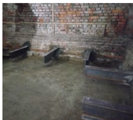
Рис. 6. Двутавровые балки-анкера
