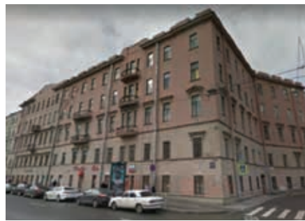
Рис. 3. Здание по ул. Декабристов, д. 31, лит. А
