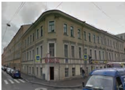
Рис. 2. Здание по ул. Декабристов, д. 36/1, лит. А (объект КГИОП «Дом Кокушкина»)
